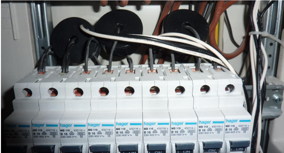
Tres convertidores de corriente de 16 A en la caja de fusibles
